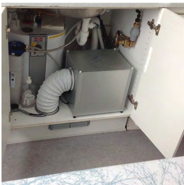
DF05 Indbygning Installation
