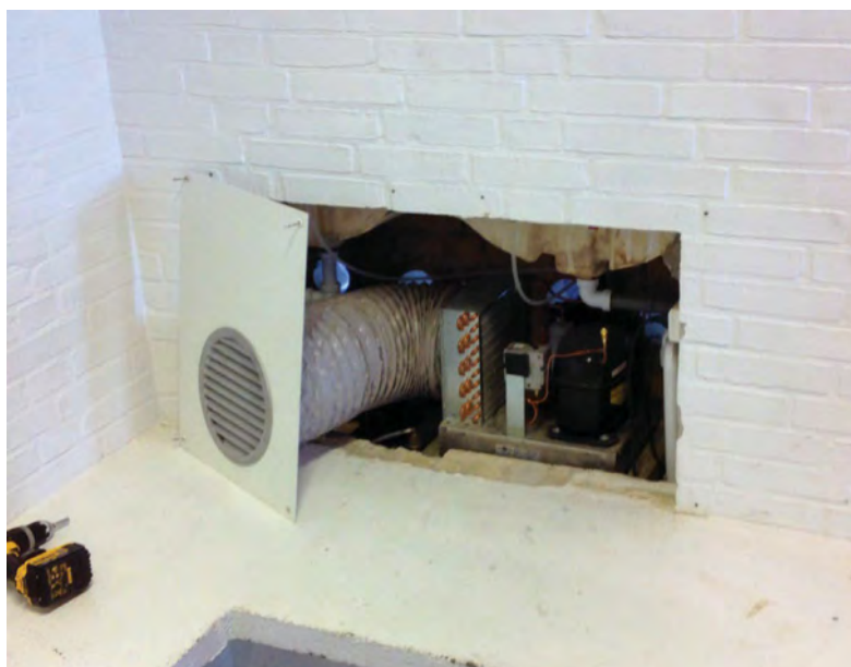
DF12 Indbygning Installation
